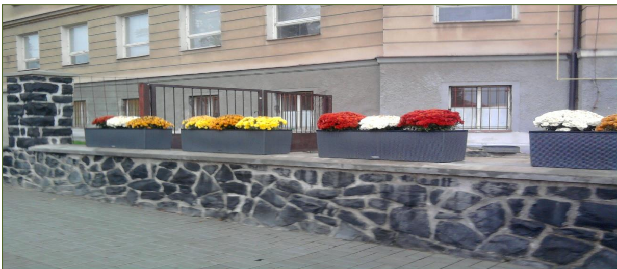
Dokončení opravy plotu
