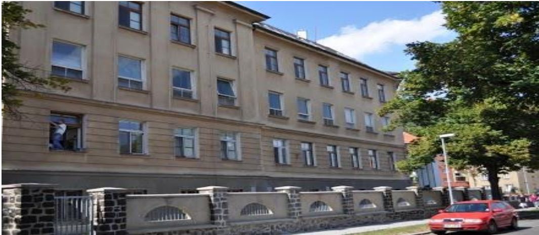
I. etapa výměny oken
