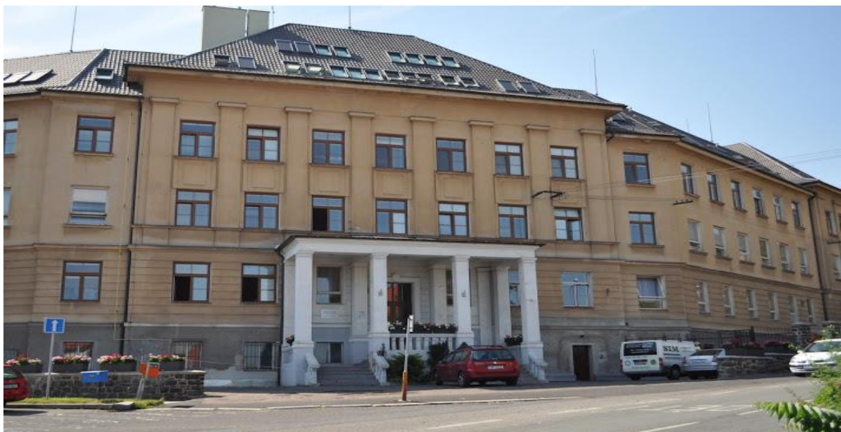
Sociální zařízení před opravou
